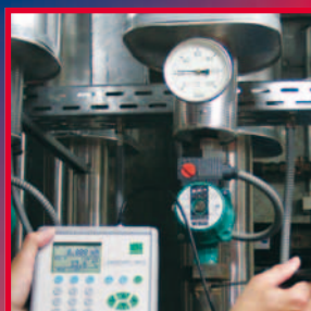
Überprüfung einer Heizanlage
